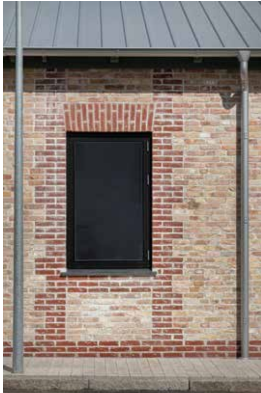
Murer Peter Christensen er glad for kalkmørtlen, men ærgerlig over, at den muligvis er for stærk til, at man kan skille stenene ad.
